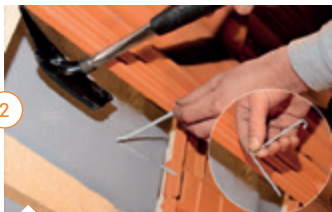
Sposób montażu klamry wbijanej
