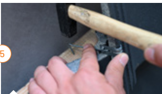
Sposób montażu klamry do dachówki na boczny rąbek, typ L
