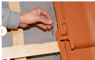
Sposób montażu klamry podwieszanej
