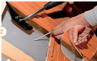
Sposób montażu klamry wbijanej
